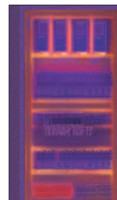
Schlechtere Luftzirkulation beim Einsatz einer Montagetafel
